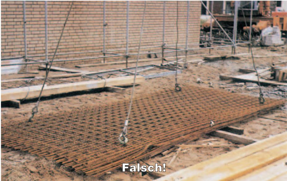
seilstropfs, die durch das Gewebe hindurchgesteckt werden (Bild 16-6).
